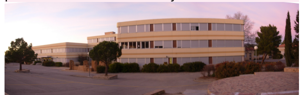
À Lambesc se trouve le seul collège de France métropolitaine construit aux normes para-sismiques : il repose sur des piliers dont la base est recouverte de caoutchouc pour amortir les secousses.
